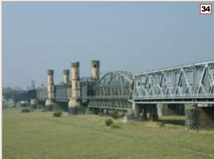
Первый железный мост через Вислу был построен в Тчеве в 1851-1857 годах. В те времена это был самый длинный мост в Европе. Эта 6-пролетная решетчатая конструкция длиной 837 м служила не только железной дороге, но и пешему и колесному транспорту. Она была украшена неоготическими башнями и въездными порталами. Однако вскоре появилась необходимость во втором мосте. Он был построен в 1888-1890 годах. Новый мост принял функции железнодорожного моста и выполняет их по сей день.
